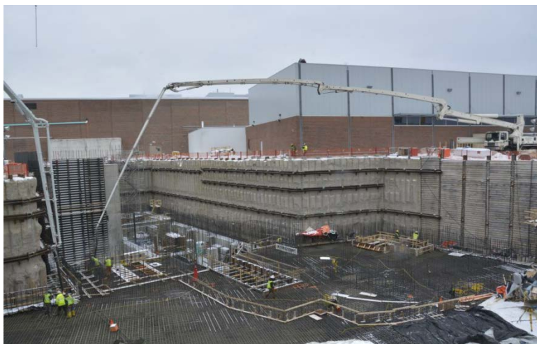
Pour for the tunnel foundation slab
